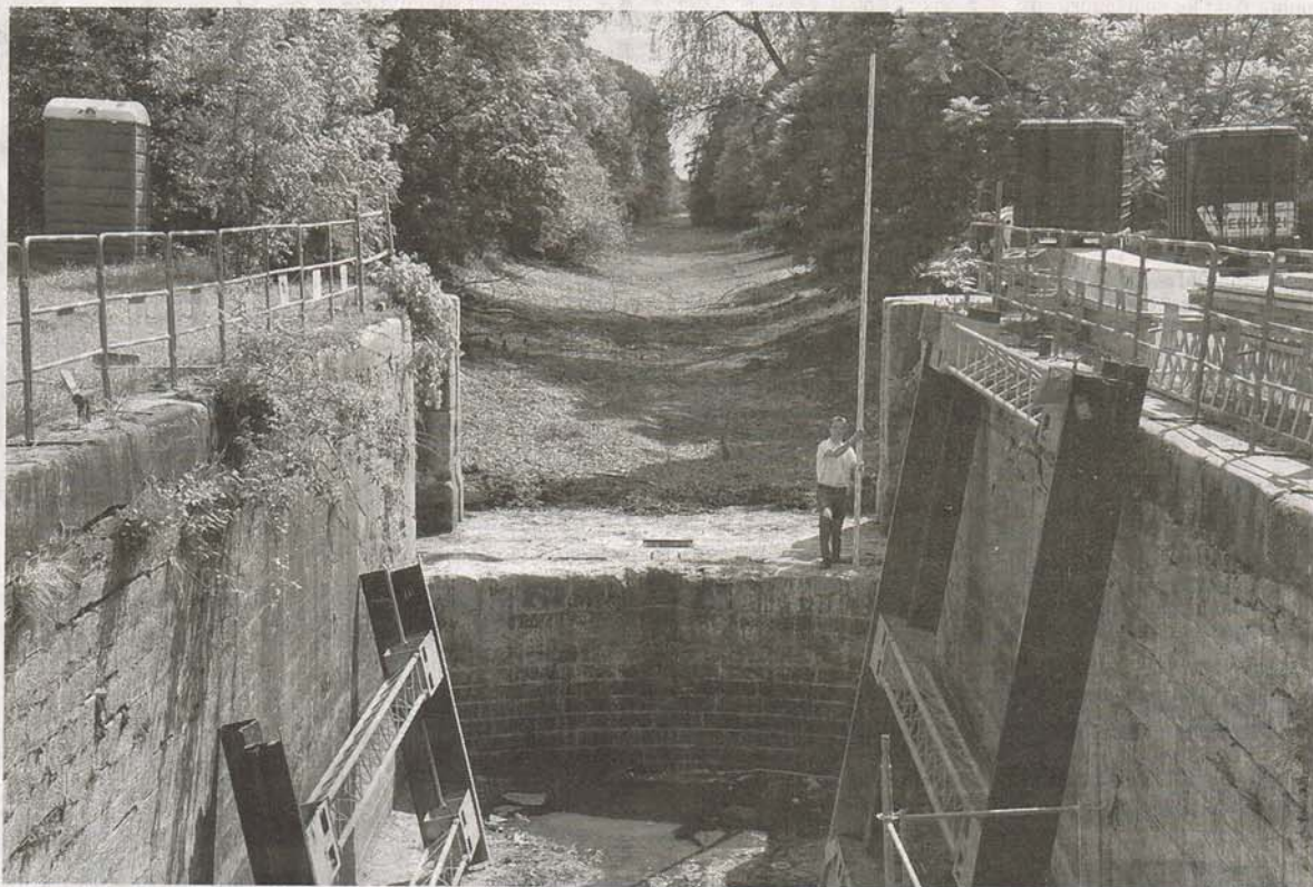
Huit des onze écluses du canal du Rhône au Rhin ont été restaurées de 2005 à 2007. Mais le boulot est à finir. PHOTO-ARCHIVES DNA
