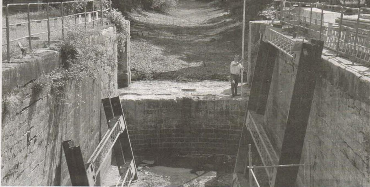
Huit des onze écluses du canal du Rhône au Rhin ont été restaurées de 2005 à 2007. Mais le boulot est à finir. PHOTO-ARCHIVES DNA
